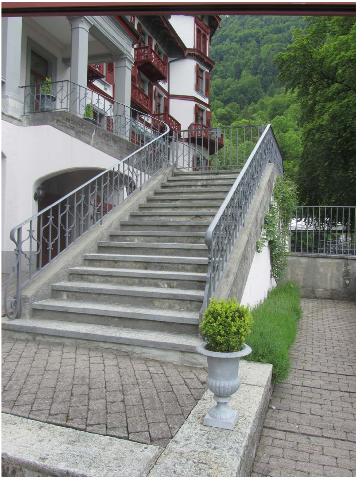
Le bel escalier d'accès au premier étage où se trouvent les salons et salles à manger.
